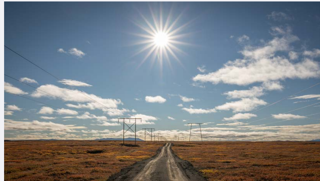
Dæmi 1. Nýleg línuslóð milli Kröflulínu 2 og 3
